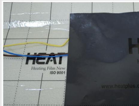
Поверх нагревательной пленки следует уложить защитный заземляющий слой **E-DERO Heat Plus™**, который необходимо подключить к проводу заземления.
