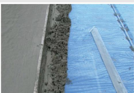
После проверки работы систему отключить от электросети и выполнить заливку стяжки (3-4 см).
