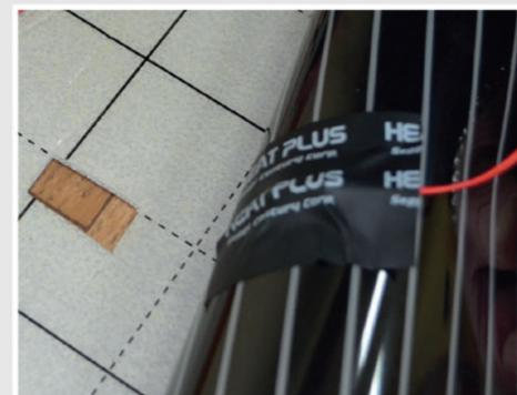
Подключить терморегулятор согласно Инструкции производителя, с выводом и закреплением термодатчика с помощью **Изоляционной Ленты Heat Plus™** на греющем элементе пленки. Для термодатчика нужно сделать углубление в основании пола и подложки во избежание механического повреждения.
