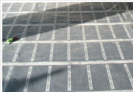
Накрыть все нагревательные элементы полиэтиленовой пленкой с запасом 10 см по периметру, и завернуть ее под нижний теплоотражатель так, чтобы получился «конверт».
