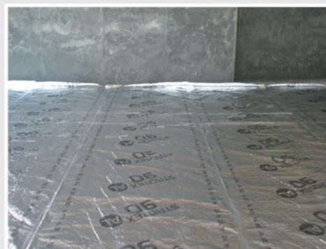
Уложить и закрепить скотчем теплоотражающую подложку **Strotex 90 AL** под нагревательными элементами пленки **Heat Plus™**.
