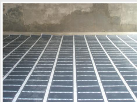
Разместить нагревательные пленки **Heat Plus™** на запланированной поверхности и закрепить скотчем. **Внимание!!!** Пленки укладывать только встык. Не допускается наложение пленок. Не укладывать под стационарную мебель, которая может ограничивать отвод тепла.
