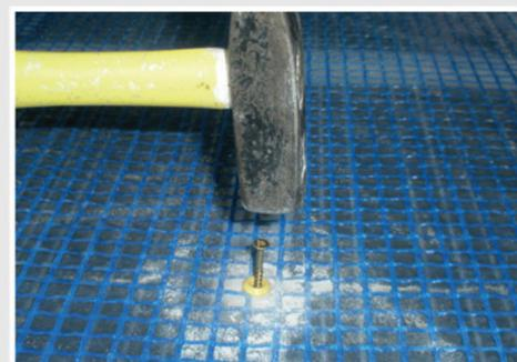
В местах отреза, где отсутствуют токопроводящие и карбоновые элементы пленок, сквозь монтажную сетку, полиэтилен, нагревательную пленку и теплоизоляцию осуществляется бурение пола буром D=6 мм. В проделанные отверстия забиваются дюбеля.
