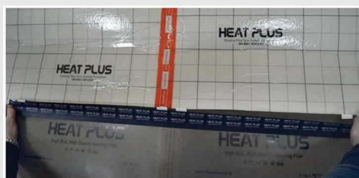
Поверх **бутилової стрічки Heat Plus™** і по лініях зрізу у всіх плівках **Heat Plus Premium** обов'язково клеїться **ізоляційна стрічка Heat Plus™**, щоб уникнути ураження електричним струмом (необхідно зробити заглиблення в підлозці під кліпси і провода).
