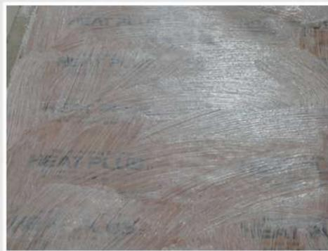
Відключити систему і нанести **Бетон-контакт** на всю поверхню плівки **Heat Plus™**.
