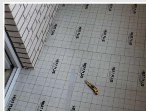
Укласти по всій площі і закріпити скотчем рулонний теплоізоляційний матеріал E-PEX або аналог.
