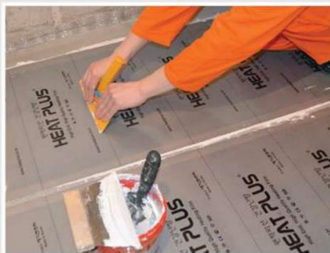
Нанести **Акриловий клей** на заздалегідь зазначену і прогрунтовану поверхню так, щоб плівка приклеїлася по всій своїй площі. Укласти плівку на клей, і ретельно вигнати залишки повітря з-під плівки.
