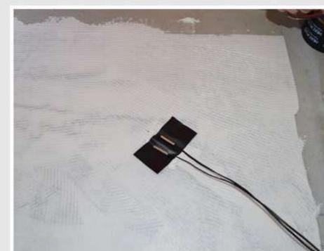
Закріпити виносний термодатчик під плівкою за допомогою ізоляційної стрічки Heat Plus™. Для термодатчика потрібно зробити заглиблення в підлозі, щоб уникнути механічного пошкодження
