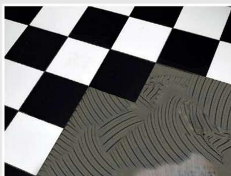
Після повного висихання **Бетон-контакту** можна укладати фінішне покриття (плитка, керамограніт і т.п.)
