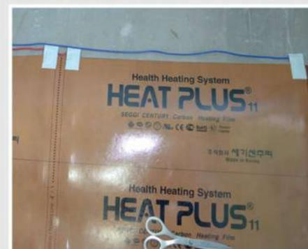
Місця з'єднань контактних кліпс, місця пайки і незадіяні кінці мідних струмопровідних шин з іншого боку плівки ретельно ізолюються за допомогою бутилової стрічки Heat Plus™, яка нарізається шматками шириною по 3,5 см.
