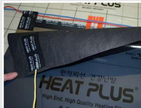
Поверх нагрівальної плівки слід укласти захисний заземлювальний шар **E-DERO Heat Plus™**, який необхідно підключити до проводу заземлення.
