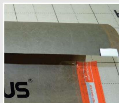
Місця з'єднань контактних кліпс, місця пайки і незадіяні кінці мідних струмопровідних шин з іншого боку плівки ретельно ізолюються за допомогою **бутилової стрічки Heat Plus™**, яка нарізається шматками шириною по 3,5 см.
