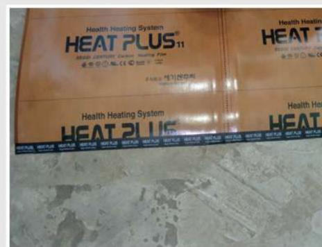
Поверх бутилової стрічки Heat Plus™ і по лініях зрізу у всіх плівках Heat Plus Premium обов'язково клеїться Ізоляційна стрічка Heat Plus™ щоб уникнути ураження електричним струмом (необхідно зробити заглиблення в підлозі під кліпси й провода).
